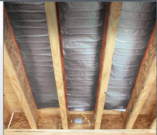
La natte de sous-plancher UnderFloor est compatible avec n'importe quel revêtement de sol, avec une isolation totale maximale de R-11 pour toutes les couches. Les températures de plancher à surface dure peuvent augmenter de 8,33 degrés Celsius (15 degrés Fahrenheit).
